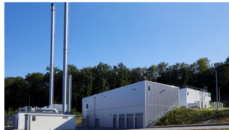
Stromnetzintegration: Windpark, Elektrolyseur, Heizzentrale der DLR-Standortversorgung in Lampoldshausen
