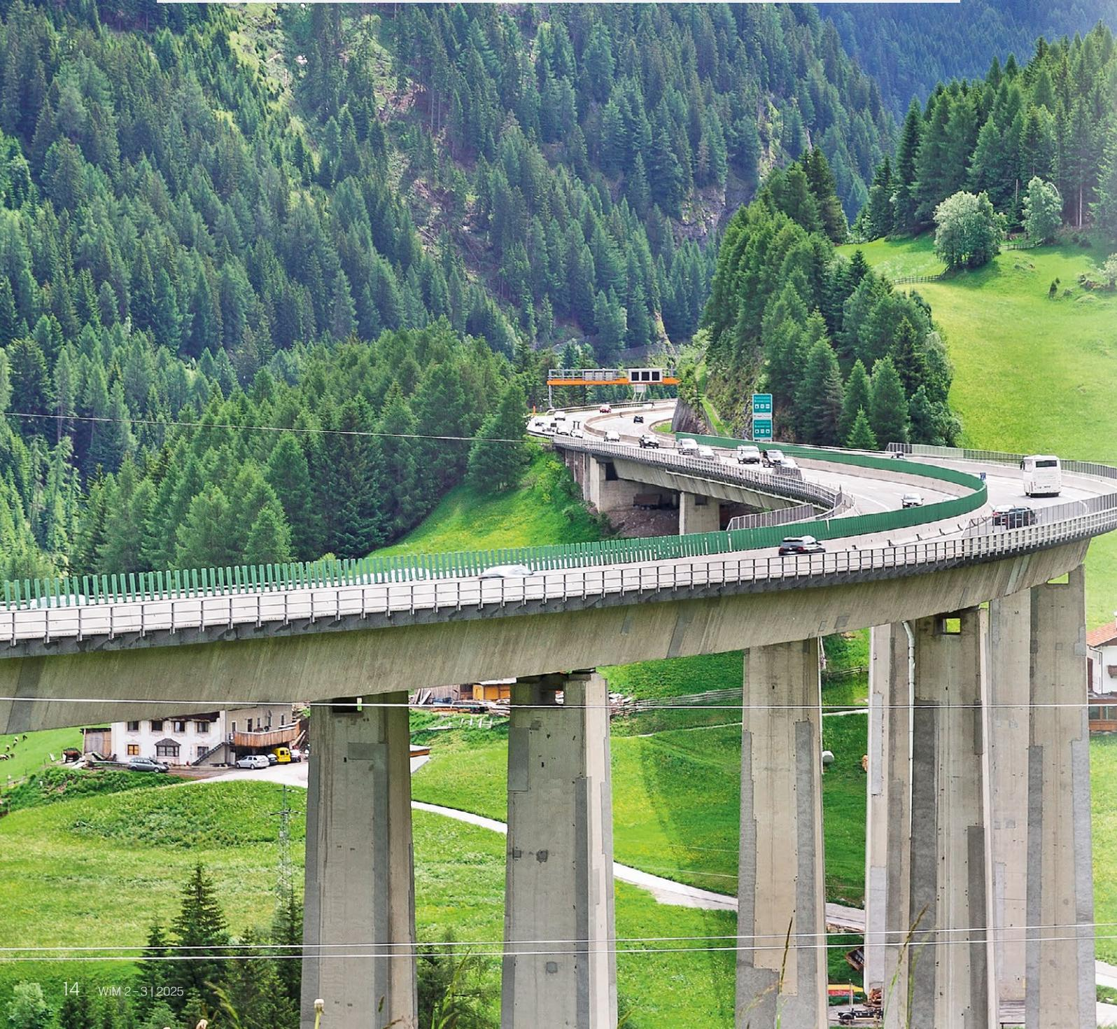
**D**ie Infrastruktur auf der Brenner-Strecke – der Hauptverkehrsader von und nach Italien – ist arg in die Jahre gekommen: Die Statik der Brücken auf der Brenner-Autobahn wurde gemäß den Anforderungen der 1950er Jahre dimensioniert, einige Bauwerke sind marode. Neubauten und umfassende Sanierungen sind also unausweichlich – aus Gründen der Sicherheit und um den heutigen Verkehrsströmen gerecht zu werden.
